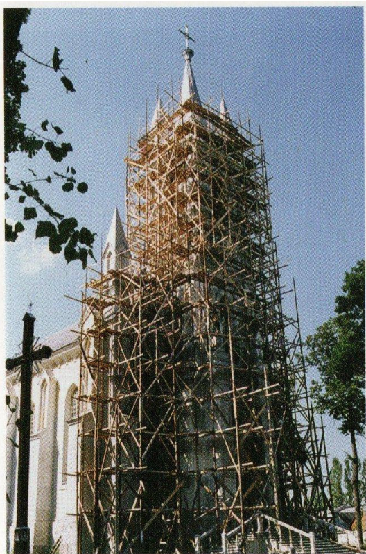
Lukšių bažnyčios remontas 1996 m.
